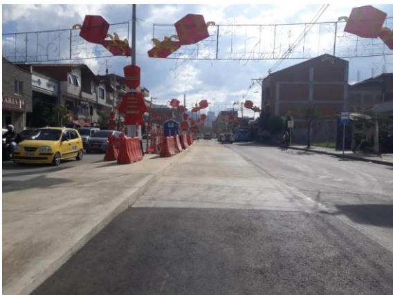
Pavimento de vías en la Carrera 43 A por calle 36 Sur
