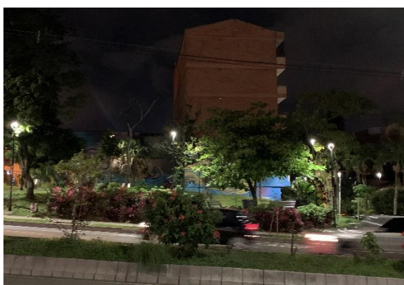
Alumbrado público del corredor
