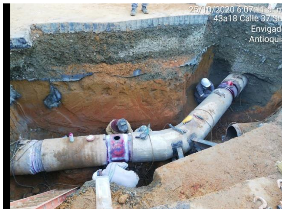
Empalme conducción Ayurá
