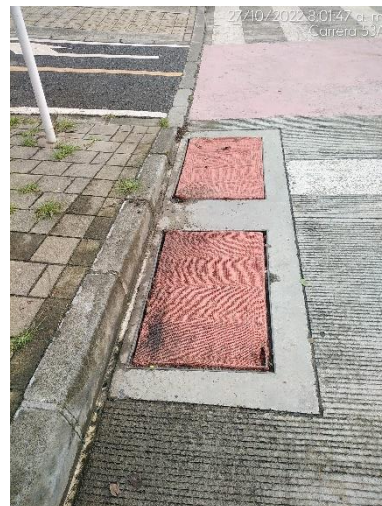
Fotografía 8 Protección de sumideros
